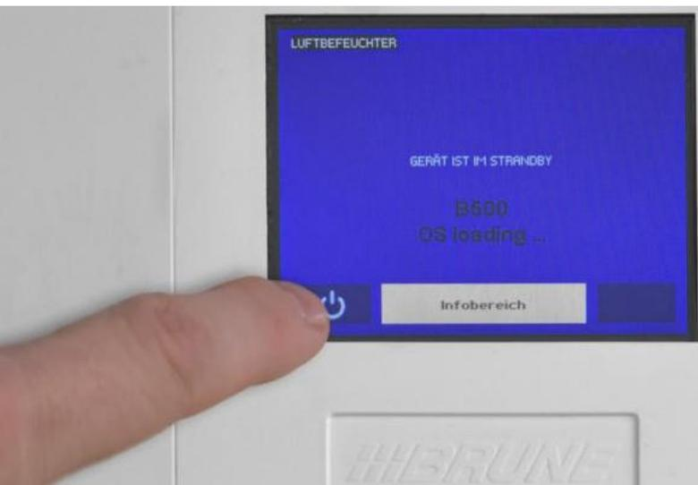
Abb. 4.3.6: Luftbefeuchter anschalten
